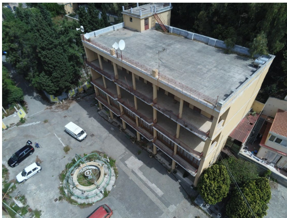
Figura 14 - Foto dal drone
