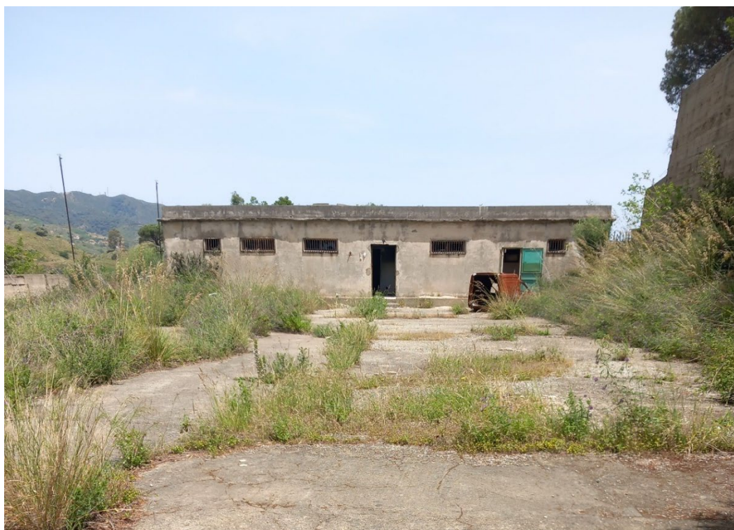
Figura 38 - Foto Edificio 12 "Locale accessorio"
