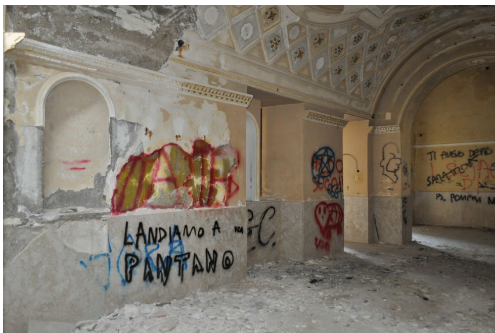
Figura 333 - Foto lato sud-ovest
