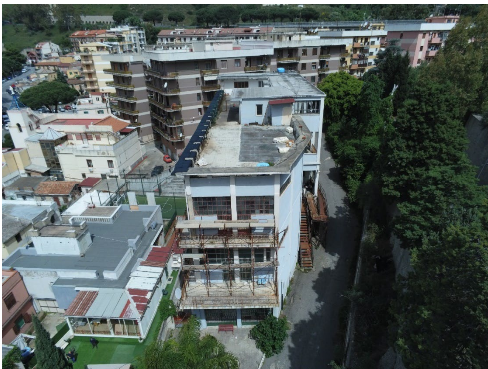
Figura 4 - Foto dal drone
