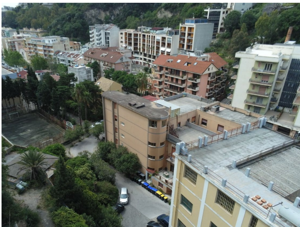
Figura 10 - Foto dal drone
