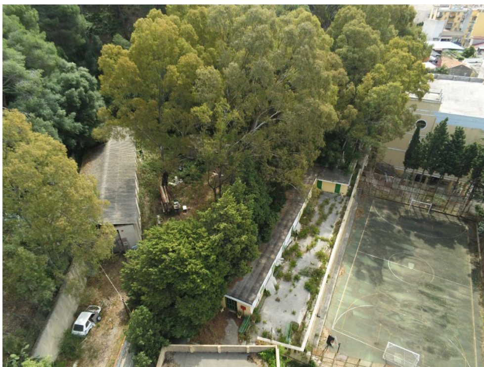
Figura 36 - Foto dal drone Edificio 7 "Padiglione XXV" e Edificio 8 "Locale tecnico"
