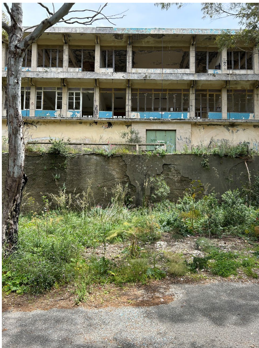
Figura 24 - Foto della facciata principale
