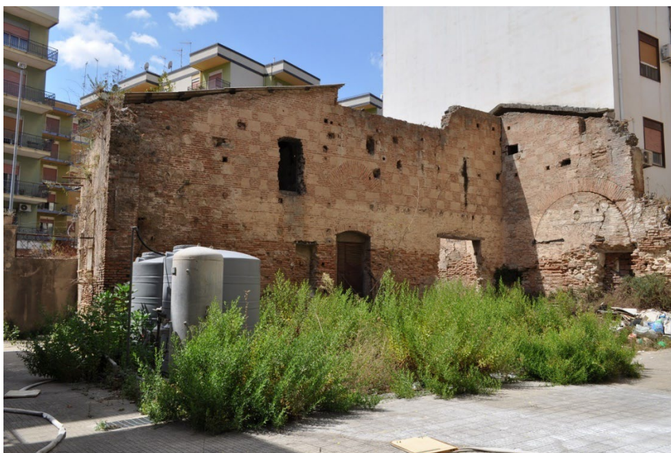
Figura 21 - Foto facciata retrostante
