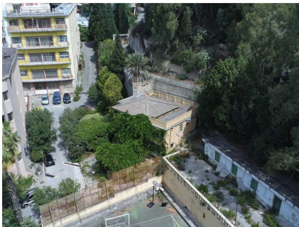
Figura 17 - Foto dal drone
