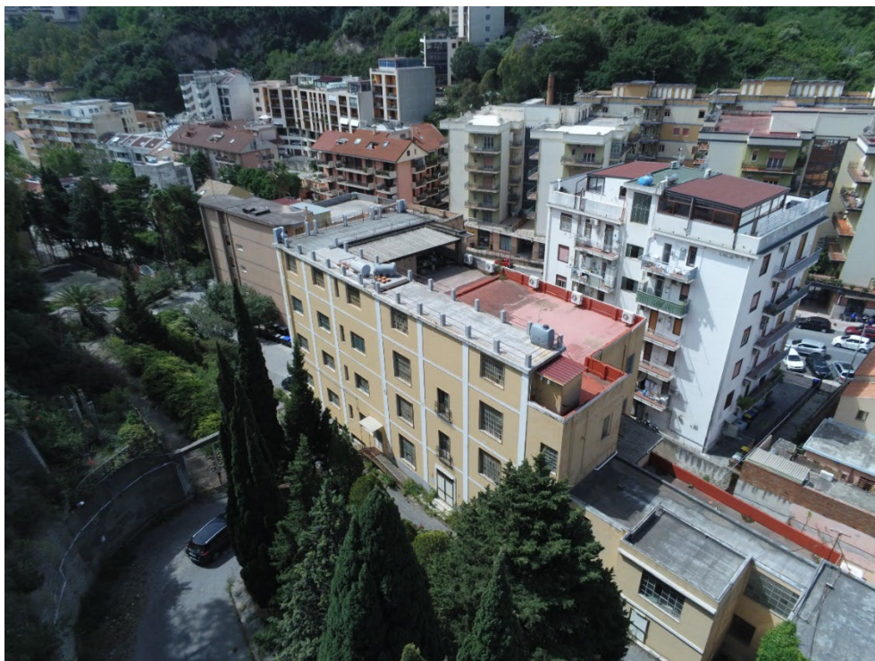
Figura 7 - Foto dal drone
