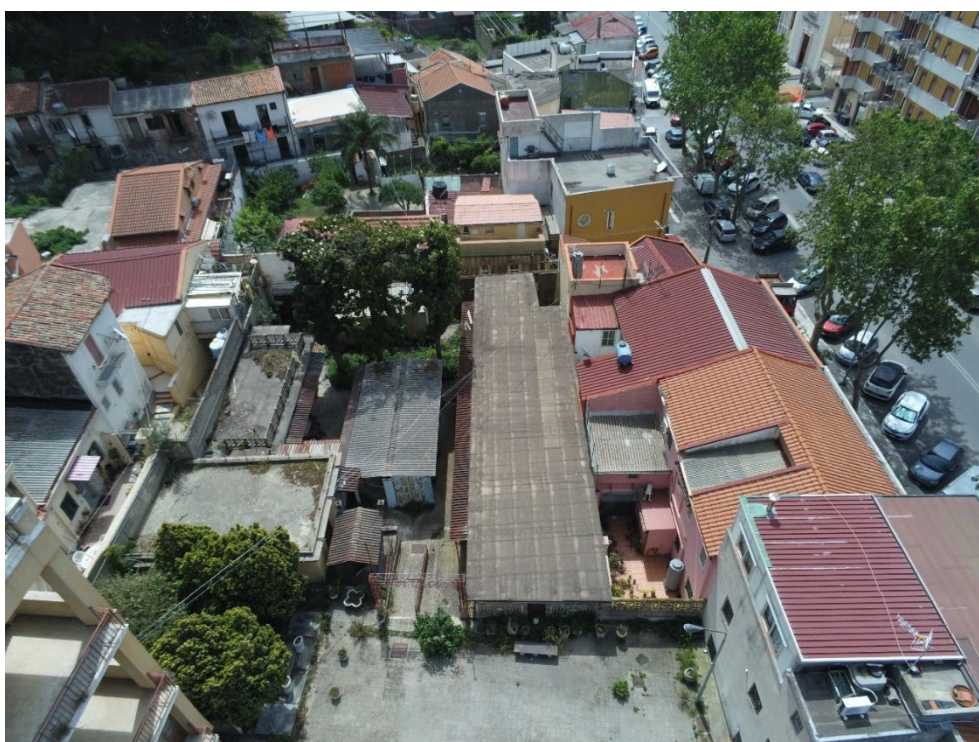
Figura 37 - Foto dal drone Edificio 11 "Aggregato case"
