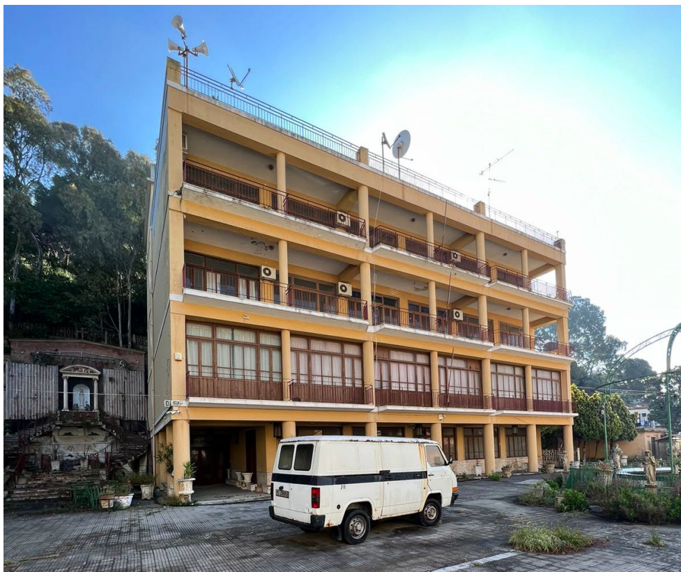
Figura 15 - Foto facciata principale
